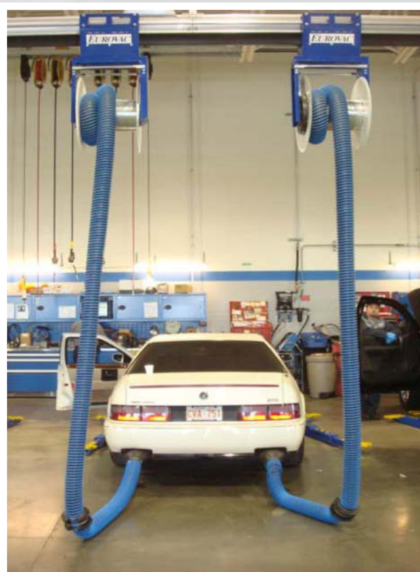
Enrouleurs à ressorts avec chariots sur rail
