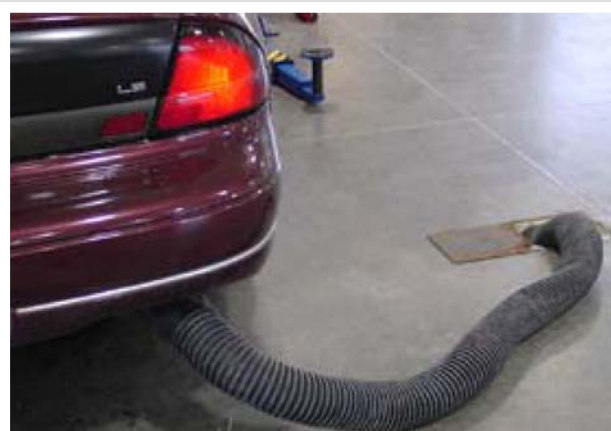
Système d'évacuation intégré dans le plancher
