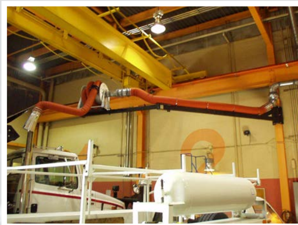
Extension sur pivot avec enrouleur pour une portée accrue
