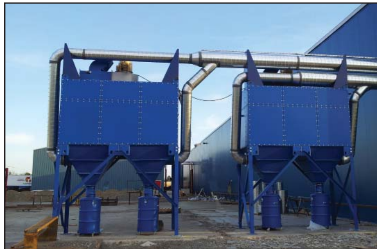
Les dépoussiéreurs Eurovac RCC (Rectangular Cartridge Collector) avec conception modulaire permettent une grande variété d'installations avec des débits d'air élevés.
